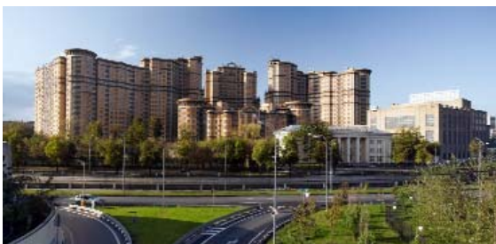
Tổ hợp nhà ở mới xây dựng tại thành phố Mátxcova
